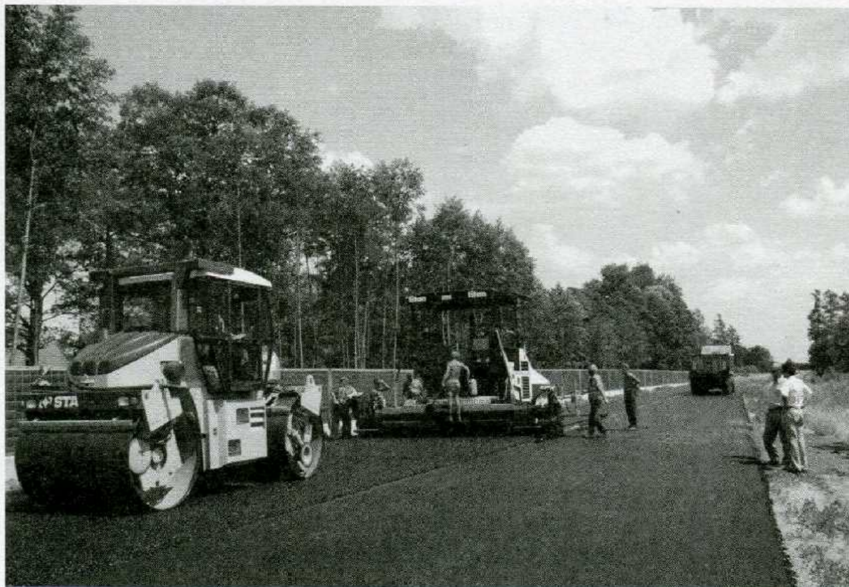
Budowa nowotomyskiej obwodnicy - lipiec 2006 r.
