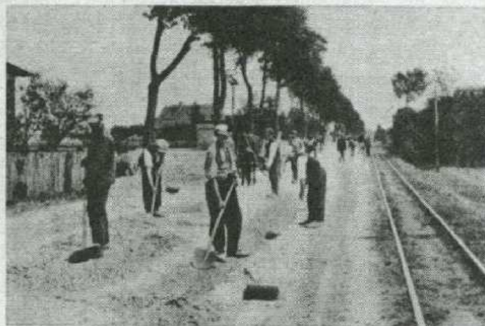
Prace drogowe na szosie państwowej odcinek Opalenica—Lwówek
