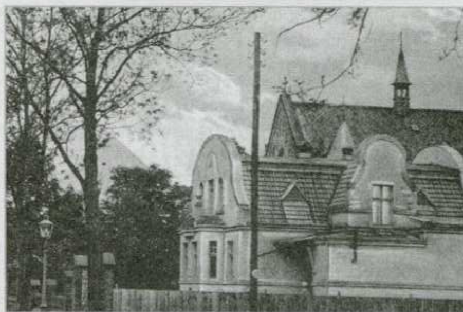
... przyglądamy się budowie probostwa ...
