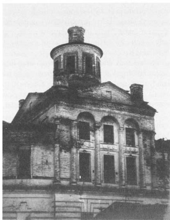
2. Wspomniana w tekście cerkiew w Wotczy - zamieniona przez bolszewików na magazyn nawozów i paliw - budynek w runie - stan z czerwca 1940 roku
