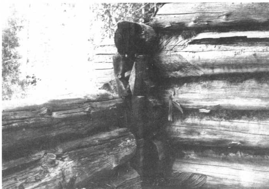
1. Konstrukcja baraku z osady pod specjalnym nadzorem NKWD - budowanych i zamieszkiwanych przez zesłańców w tajdze - stan z czerwca 1940 roku
