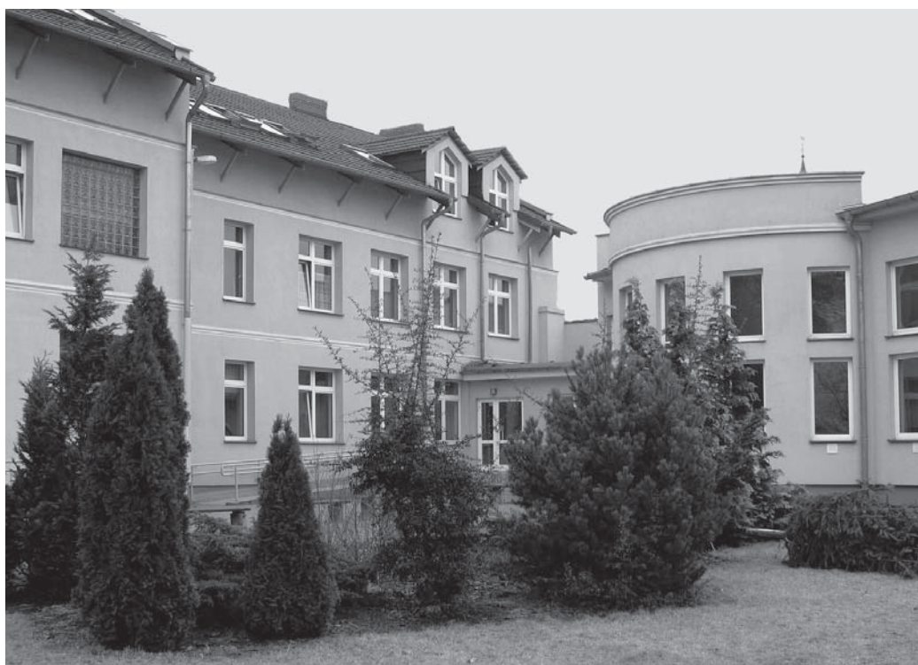
Budynek Gimnazjum - z nieco innej perspektywy...
