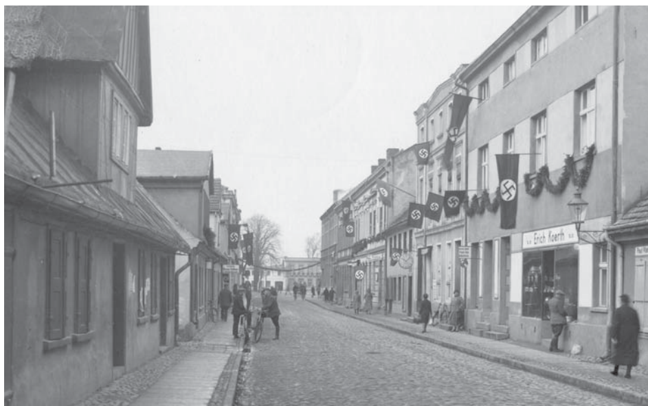
Ulica Mickiewicza - Goldstrasse , 1940 r.
