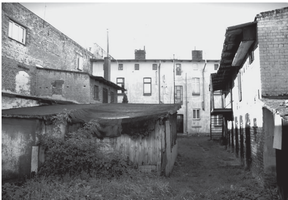
Kamienica przy ul. Długiej 9 - widok od strony podwórza
