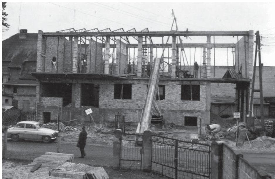
Nowotomyski Dom Rzemiosła w budowie - 1970 r.
