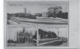
Budowle i budowle w Opalenicy. Ze zbiorów Biblioteki Uniwersyteckiej w Poznaniu
