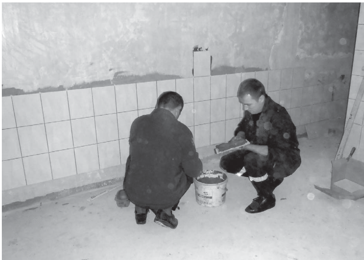
Dzięki strażakom mającym zdolności do majsterkowania i prac remontowych mamy płytki w łazience, wymienione we własnym zakresie drzwi, okna
