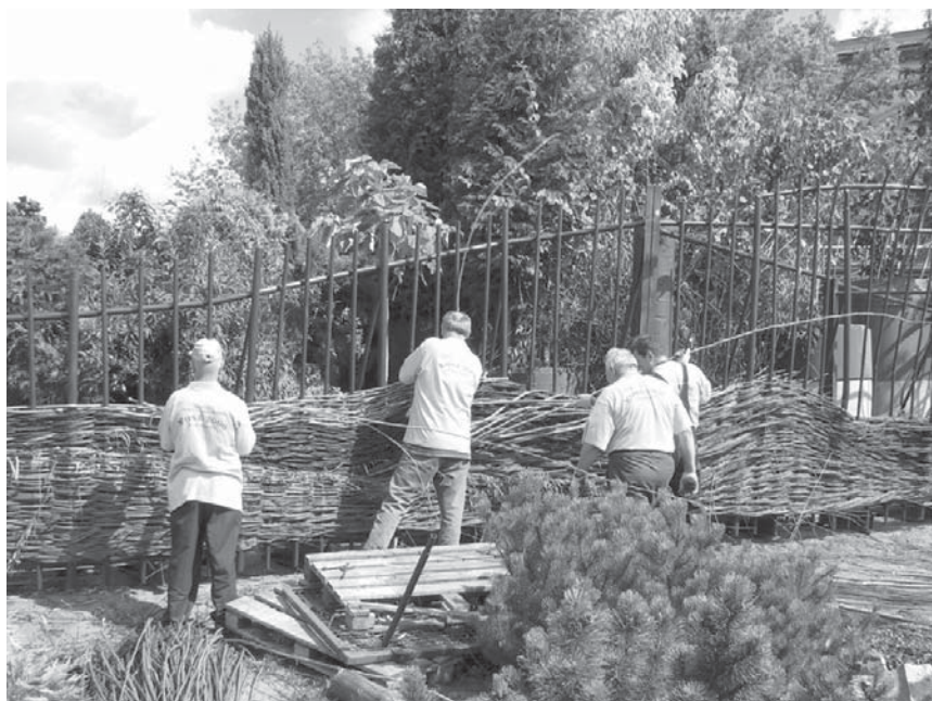
Kosz 2006 w budowie
