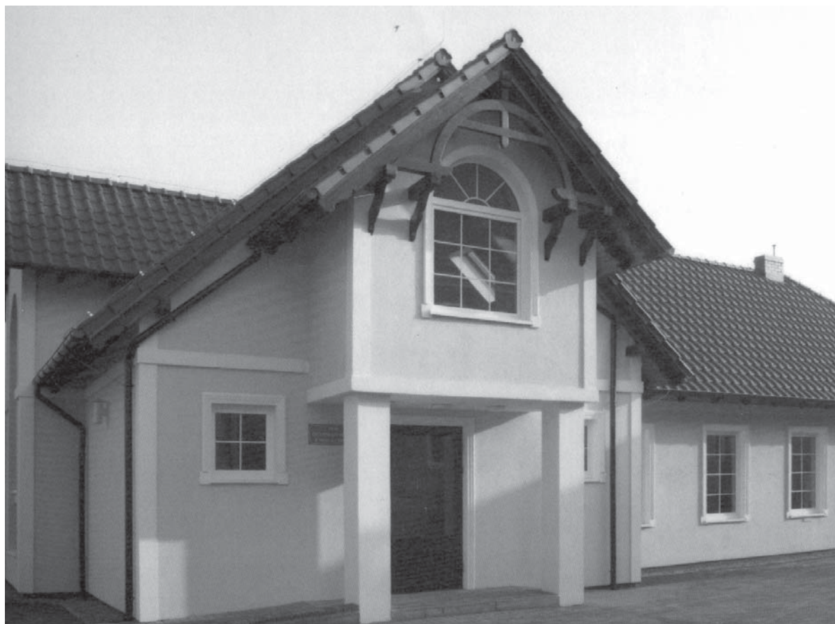
Dom Dziennego Pobytu powstał w ciągu jednego roku
