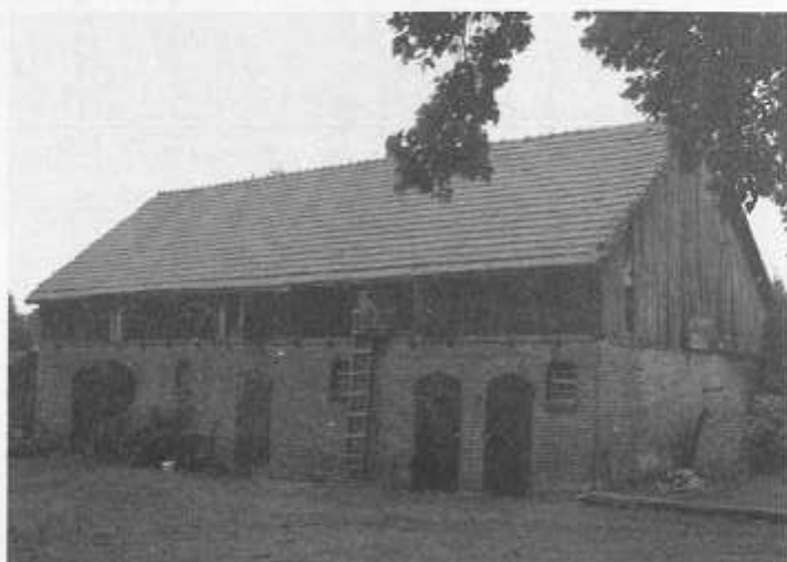
Budynek gospodarczy murowany, z tępem całkowicie drewnianym, centrum wsi (fot. autor 2006)
