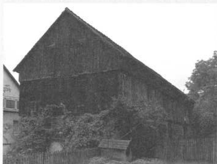
Budynek gospodarczy murowany, z tępem całkowicie drewnianym, centrum wsi (fot. autor 2006)
