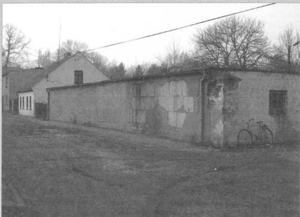
Miejsce, w którym stała lwówecka synagoga
