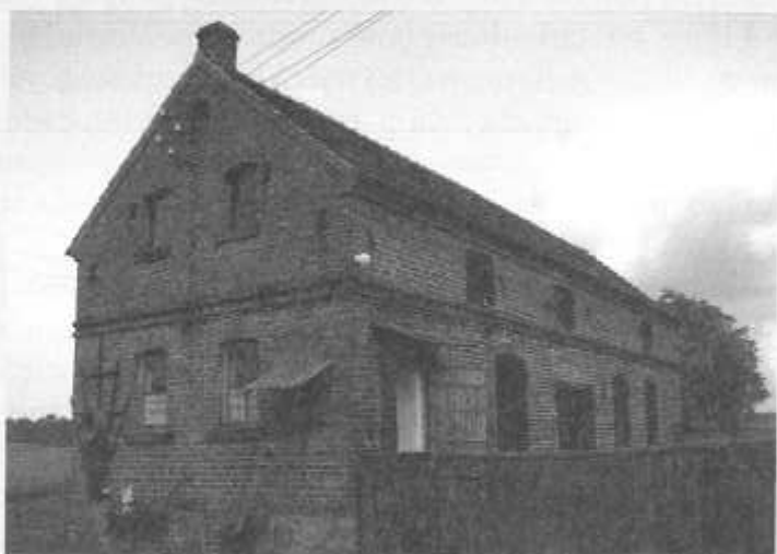
Budynek gospodarczy murowany, z murowanymi szczytami i ścianką kolankową, północna część wsi, gospodarstwo z kuźnią (fot. autor 2006)
