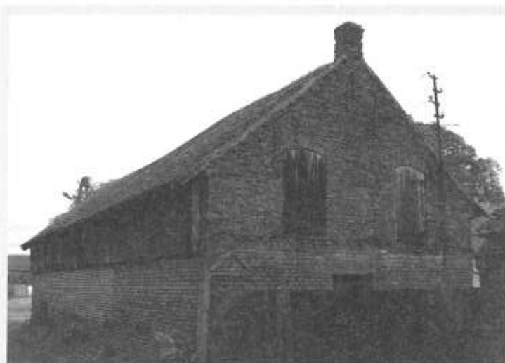
Budynek gospodarczy murowany, z murowanymi szczytami i z drewnianą ścianką kolankową, południowe skrzyżowanie dróg (fot. autor, 2006)
