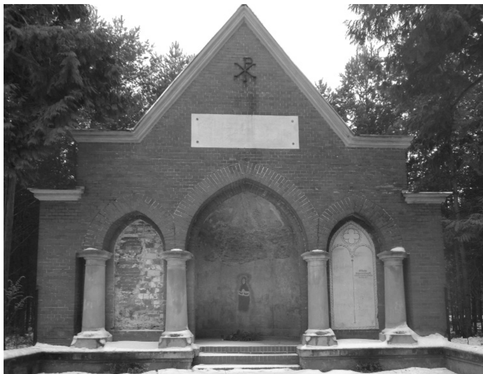
Mauzoleum rodziny Schwarzkopków
