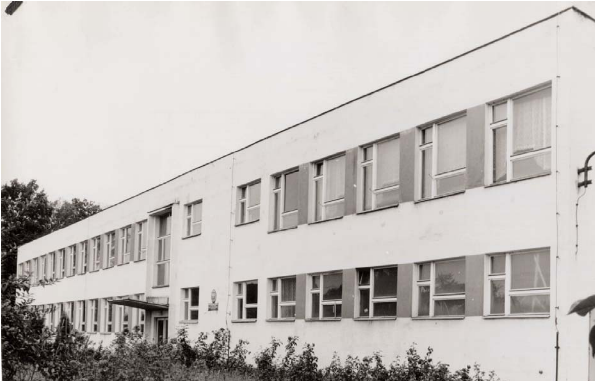
Budynek Szkoły Podstawowej w Borui Kościelnej, zbudowanej i oddanej do użytku w 1969 r. Stan z 1984 r.
