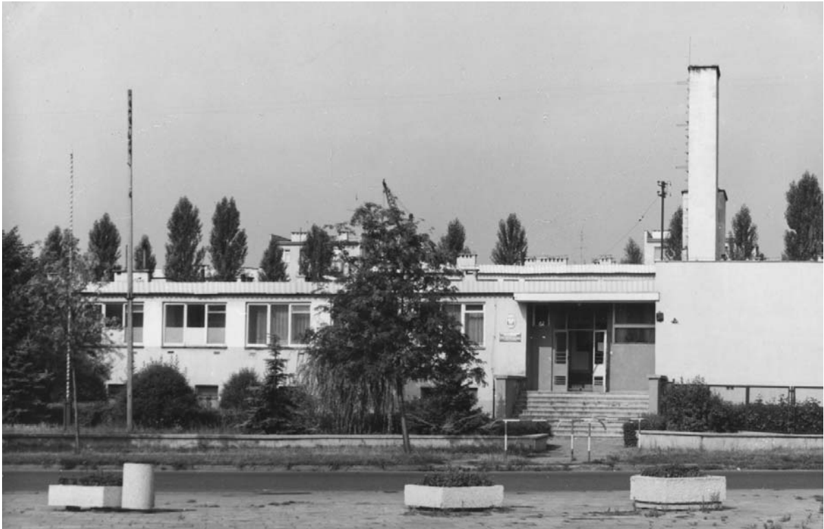
Budynek internatu Liceum Ogólnokształcącego w Nowym Tomyślu, oddany do użytku w 1968 r. Stan z 1984 r.
