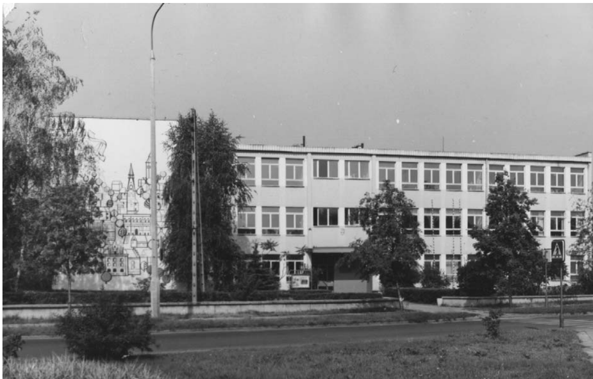
Budynek Liceum Ogólnokształcącego w Nowym Tomyslu, budowany w latach 1965-67
