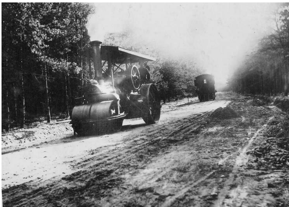
Wałowanie odcinka drogi powiatowej w Porąbnie 1929 r.
