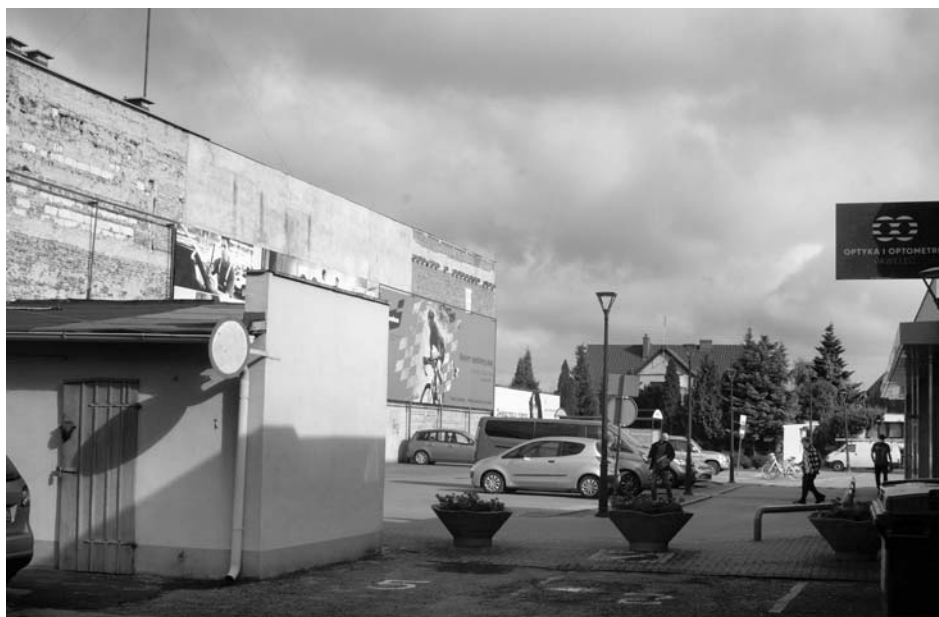
W miejscu dzisiejszego parkingu stał browar Pflauma. Fot. Wojciech Teleszyński
