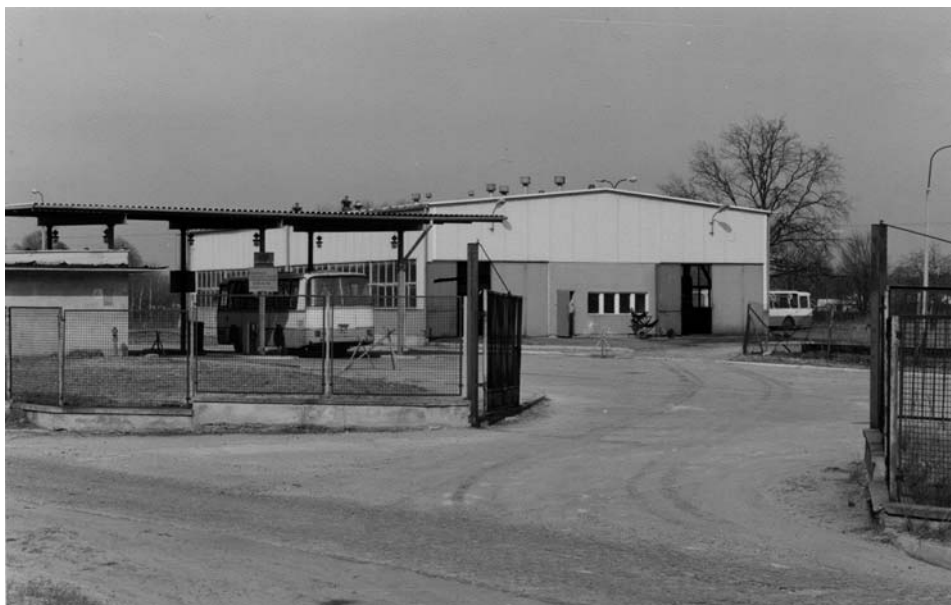
Zajezdnia autobusowa przy ulicy Targowej - 1989 r. Ze zbiorów Miejskiej i Powiatowej Biblioteki Publicznej w Nowym Tomysłu
